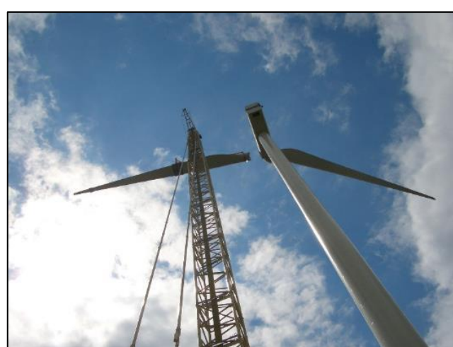
Assemblage des pales
