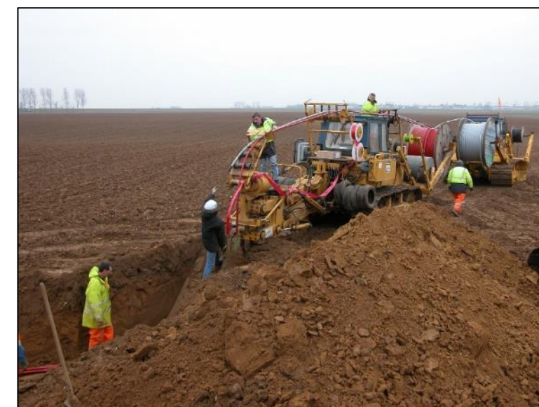
Figure 13 : Photographies d'une opération de raccordement (Source : EOLISE)
