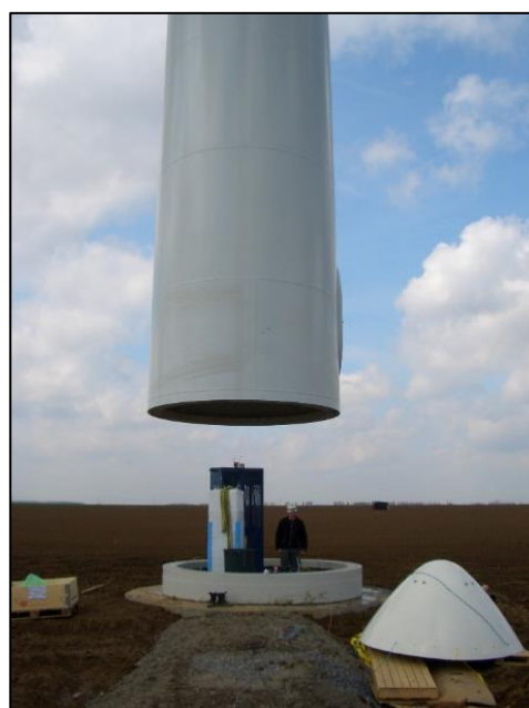
Montage de la base du mât
