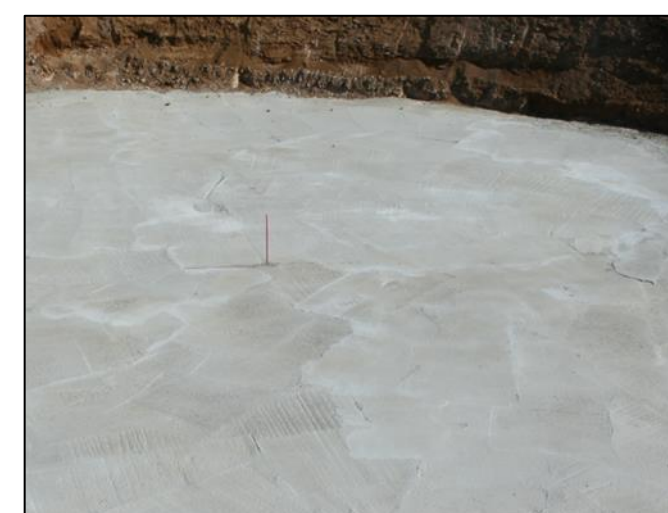
Béton de propreté
