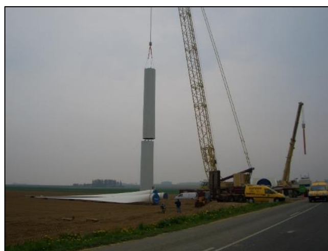
Assemblage des tronçons du mât
