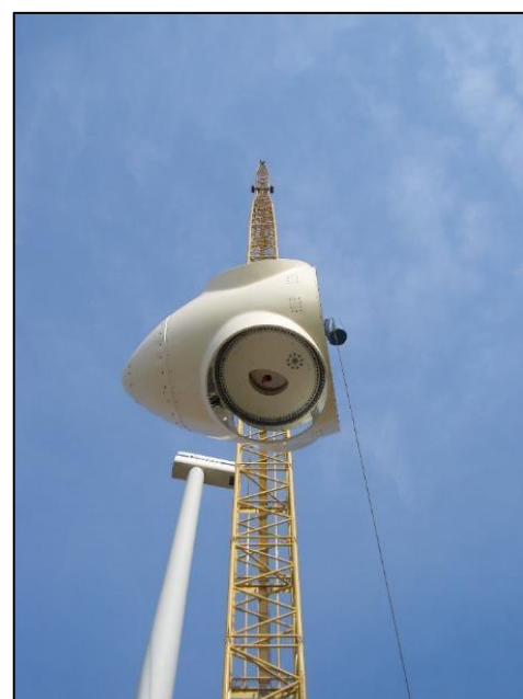
Assemblage du rotor
